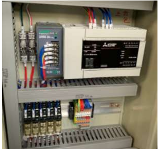
圖 11、加工設備 PLC 設備安裝
