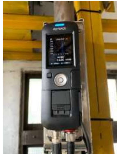
圖 14、夾鉗式氣體流量計安裝設置
