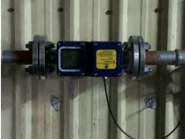
圖 17、瓦斯流量感測器安裝
